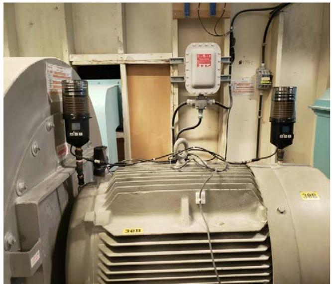
Exemples de graisseurs autonomes pilotés par ultrasons
