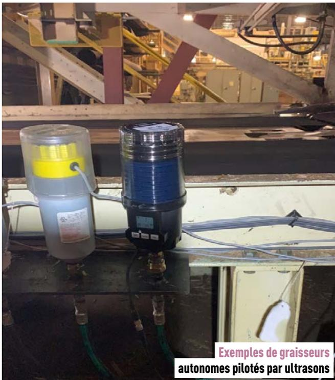
Exemples de graisseurs autonomes pilotés par ultrasons
