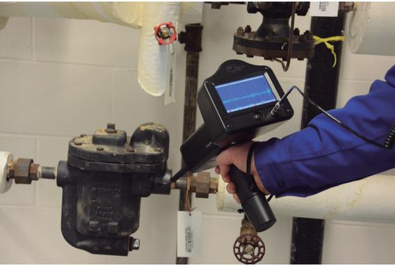
El inspector debe ser capaz de reconocer el tipo de purgador que se va a inspeccionar. Una vez que este haya sido identificado, tendrá una de dos características de sonido. El purgador tendrá un sonido de "abierto y cerrado" o un sonido de flujo continuo. Los purgadores de abierto/cerrado, o de retención/descarga/retención, son más comúnmente los purgadores de cubo invertido, disco, termostáticos y termodinámicos.
