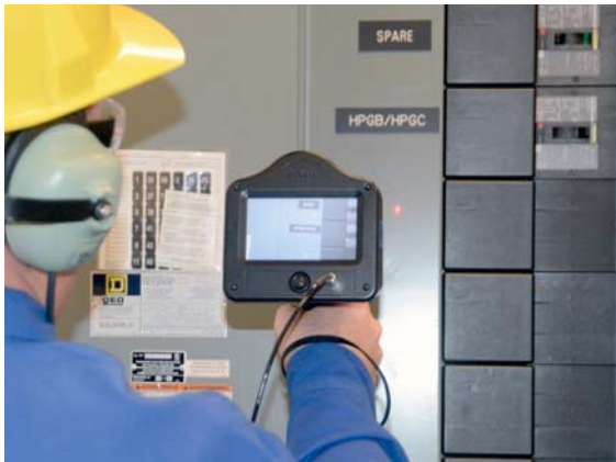
Ein Ultraschallgerät ist ein vielseitiges Werkzeug, das in jeder Umgebung verwendet werden kann. Die Technik eignet sich beispielsweise zum Auffinden von Druckluft- und Gaslecks oder zur Erkennung von ausgefallenen oder defekten Kondensatableitern. Bilder: UE Systems
